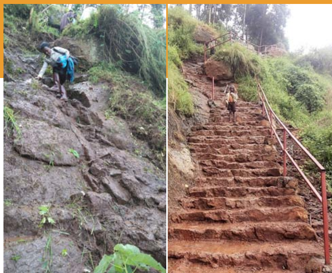
Links: der Zustand vor dem Bau der Treppe Rechts: die neue Treppe mit Geländer
